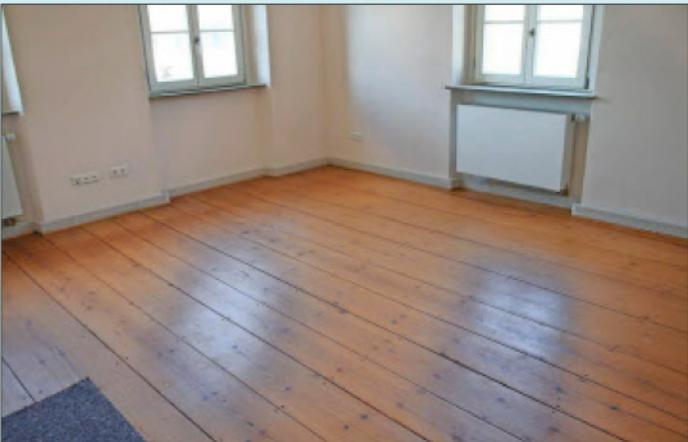
Eine Sockelheizung soll die Feuchtigkeit aus den Wänden transportieren. Die originalen Dielenböden im Obergeschoss wurden aufgearbeitet und konnten erhalten werden. Foto: gei
